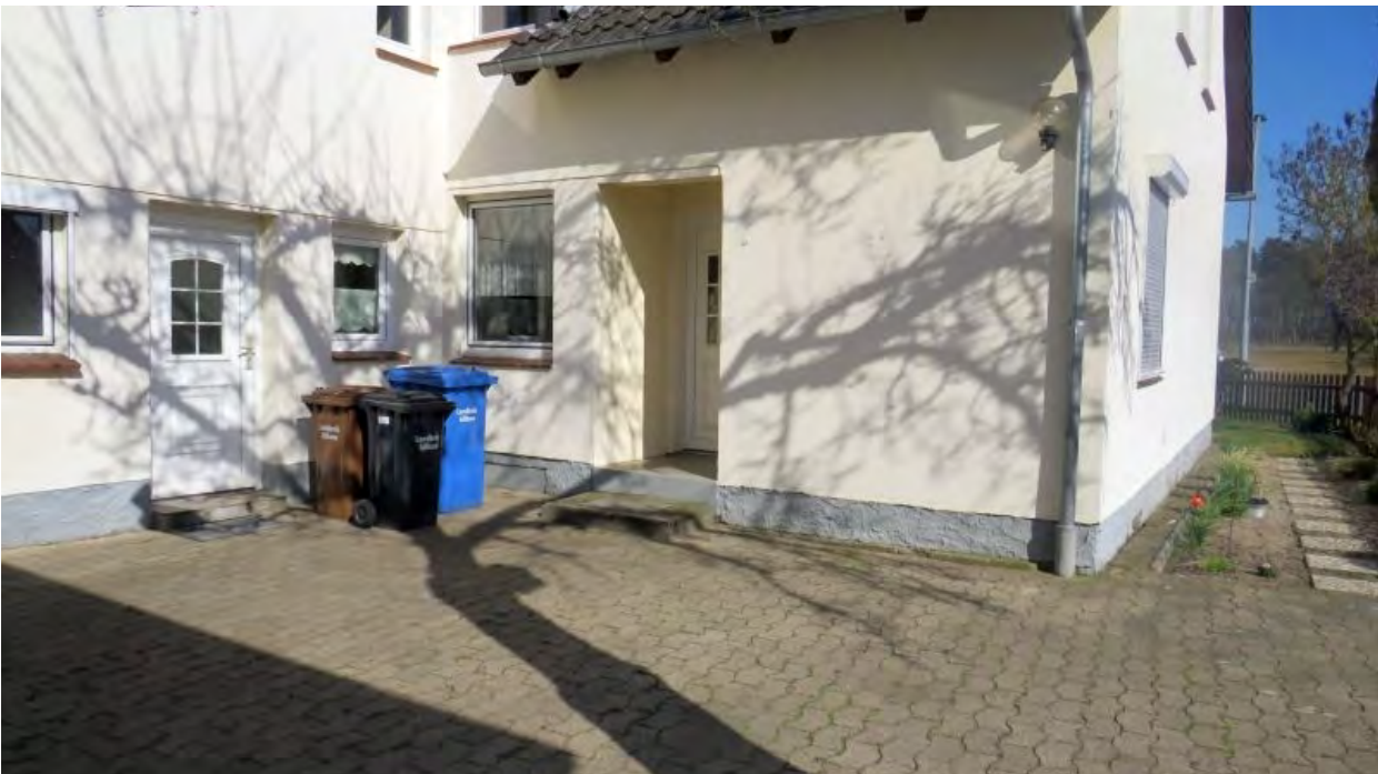
Eingangsbereich 2 vom Innenhof
