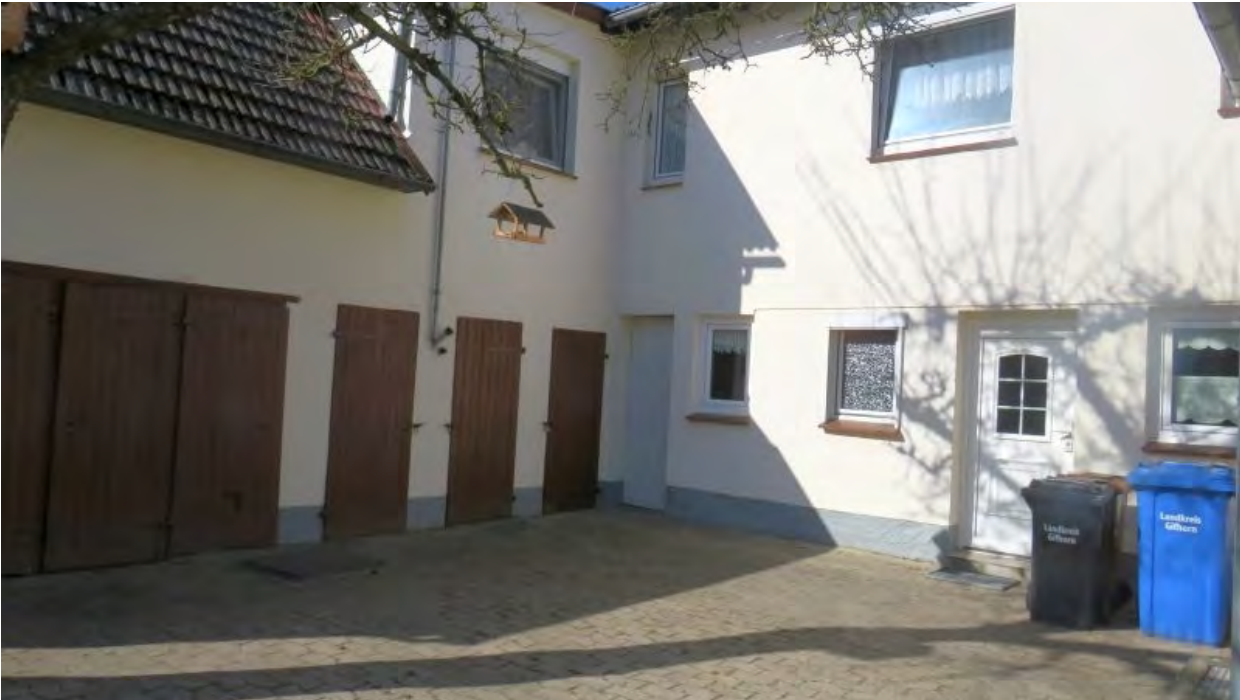
Eingangsbereich 1 vom Innenhof
